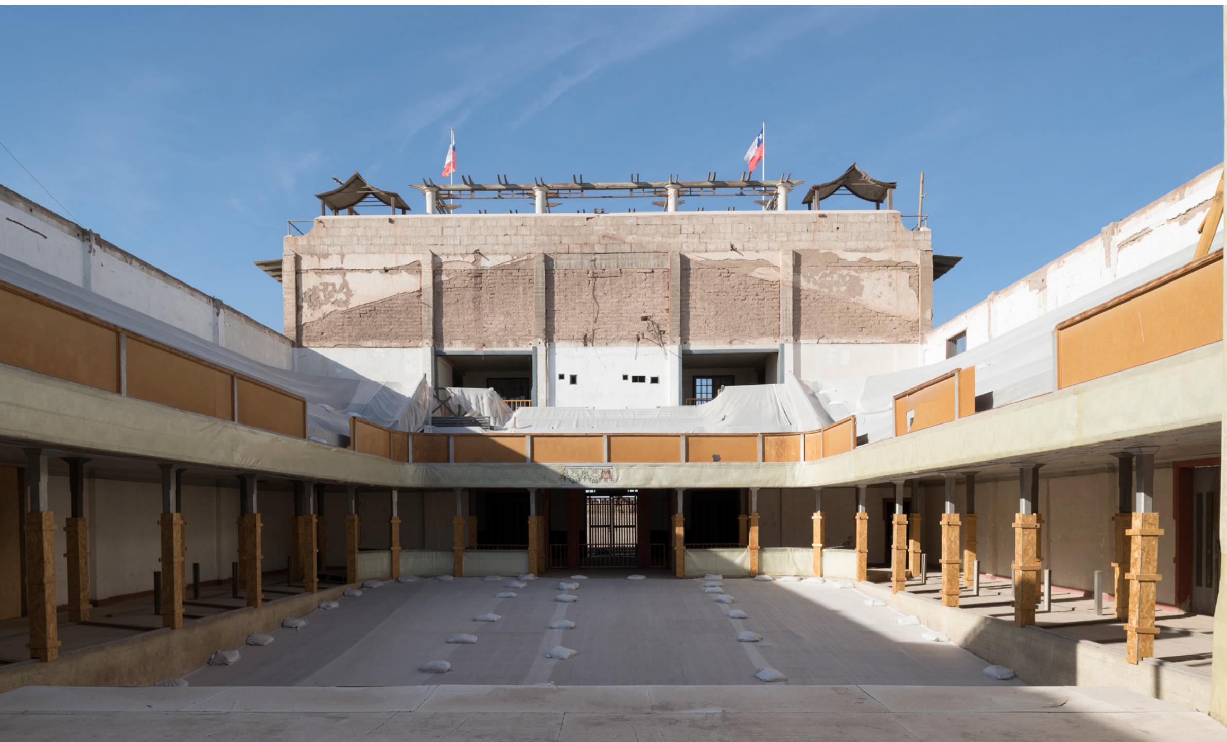
Estado del teatro Chacabuco tras los trabajos de emergencia, octubre 2023.
