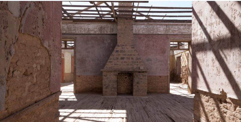
Chimenea casa del administrador, Chacabuco.
