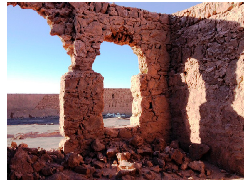
Ruinas de la Oficina de Servicio Pampa Unión, construida con diversas técnicas utilizando el “Costrón” como material de obra gruesa Fuente: S. Alfaro 2013
