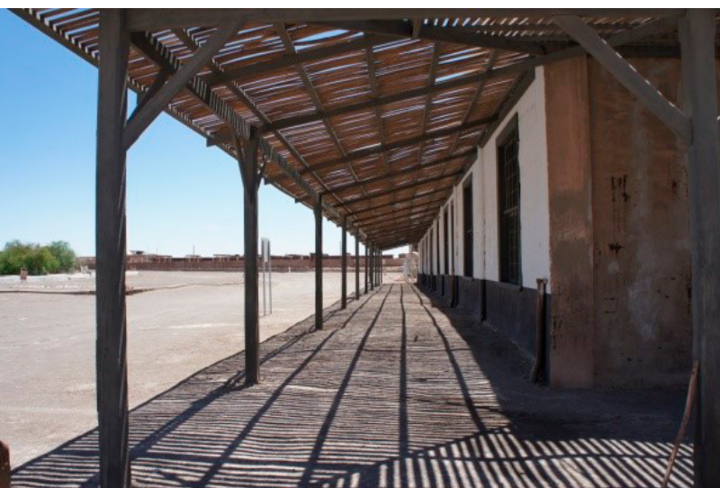
Espacio intermedio de control medioambiental.
