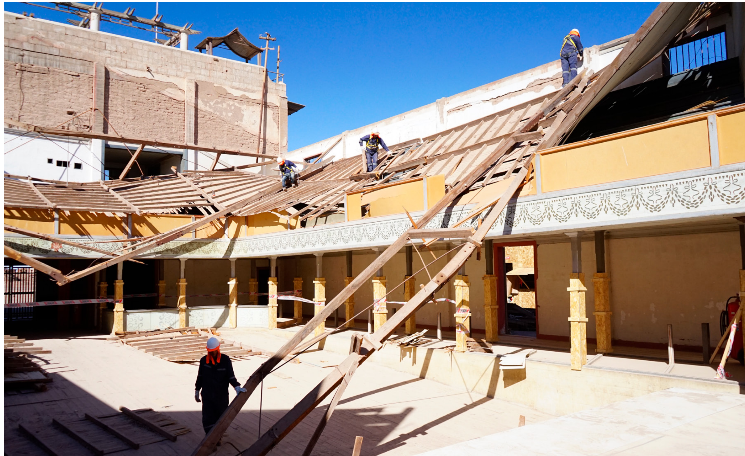
Trabajos de emergencia en el teatro Chacabuco, año 2023.
