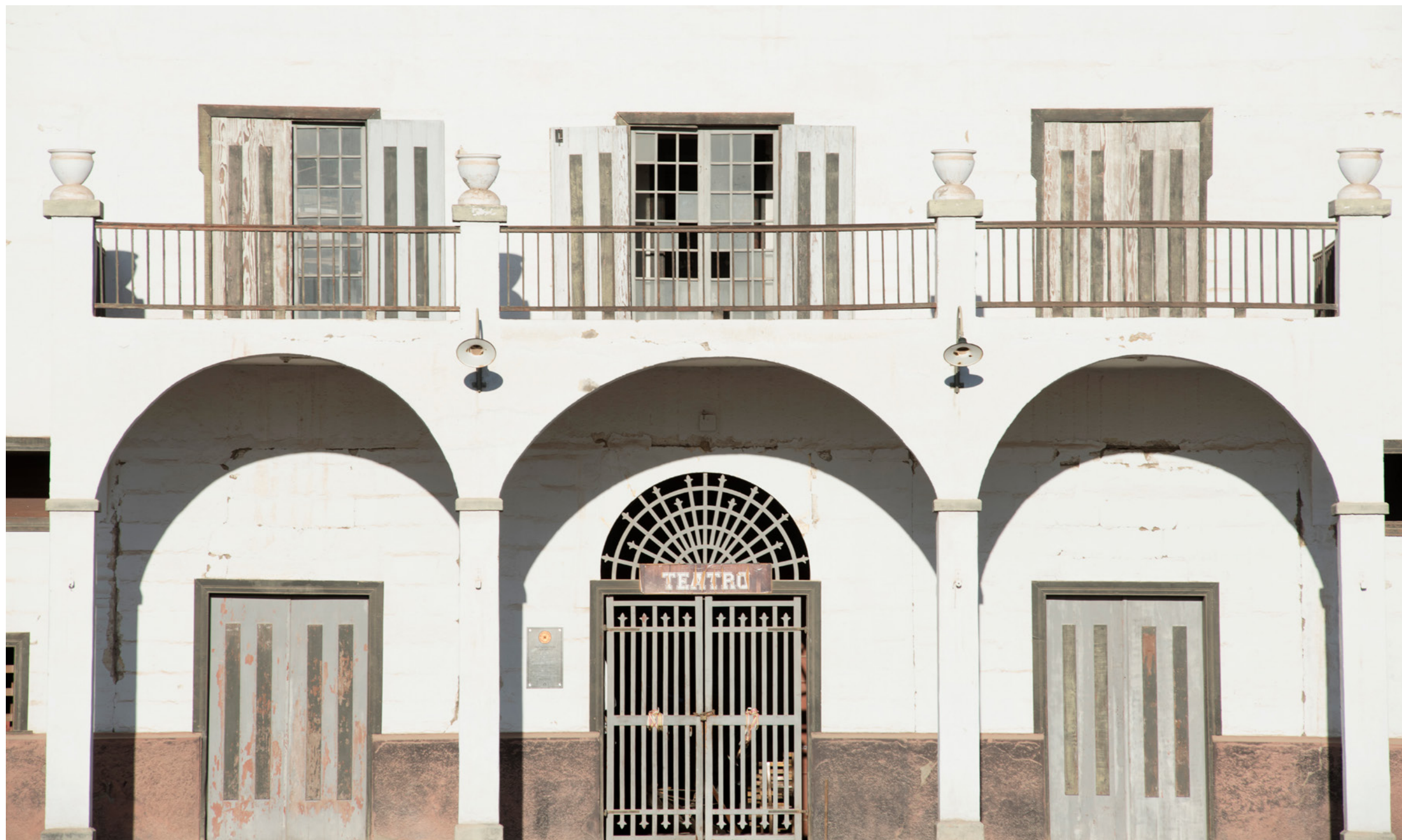
Fachada principal del teatro Chacabuco.
