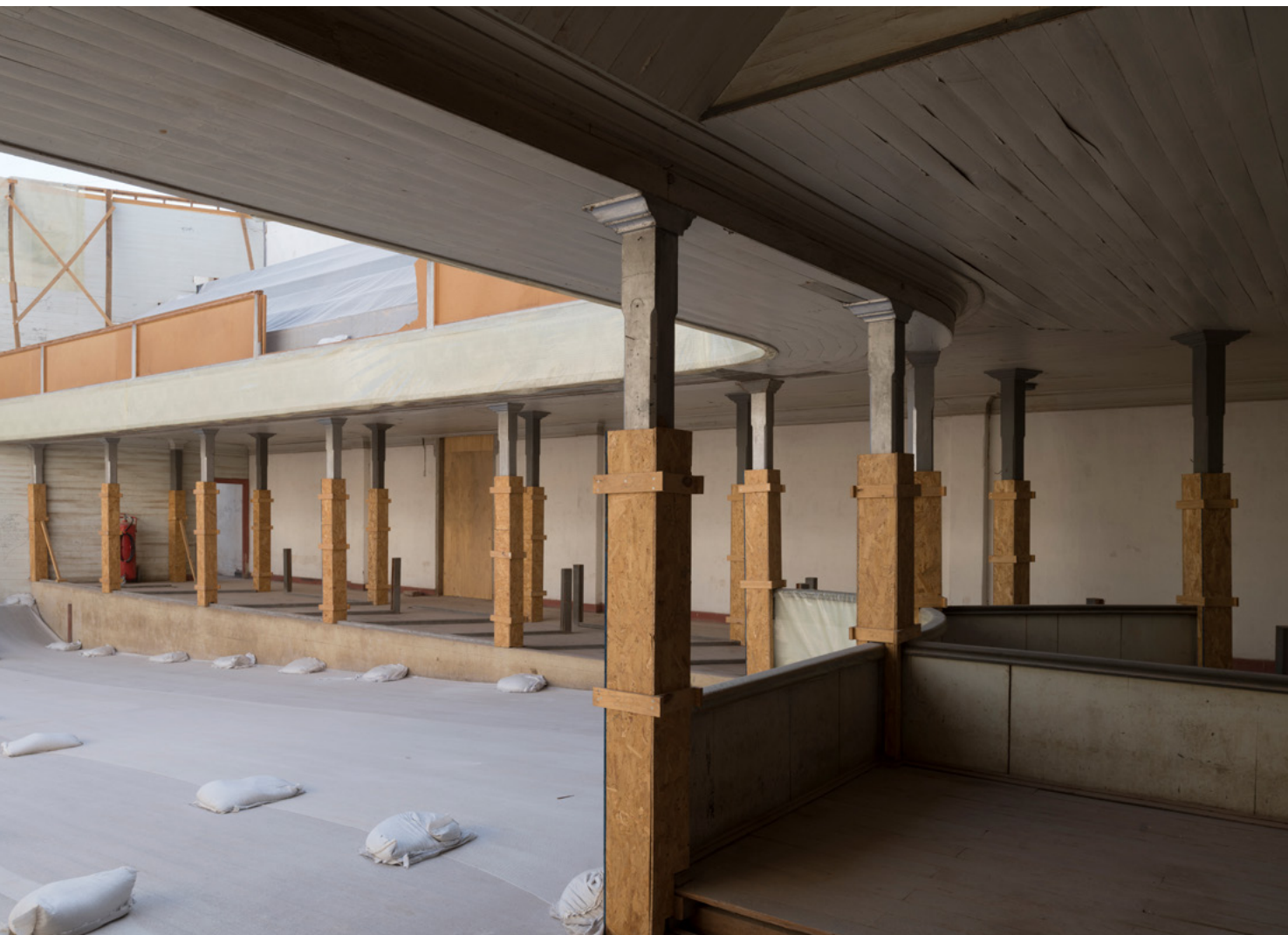
Protecciones de elementos patrimoniales del teatro en los palcos.
