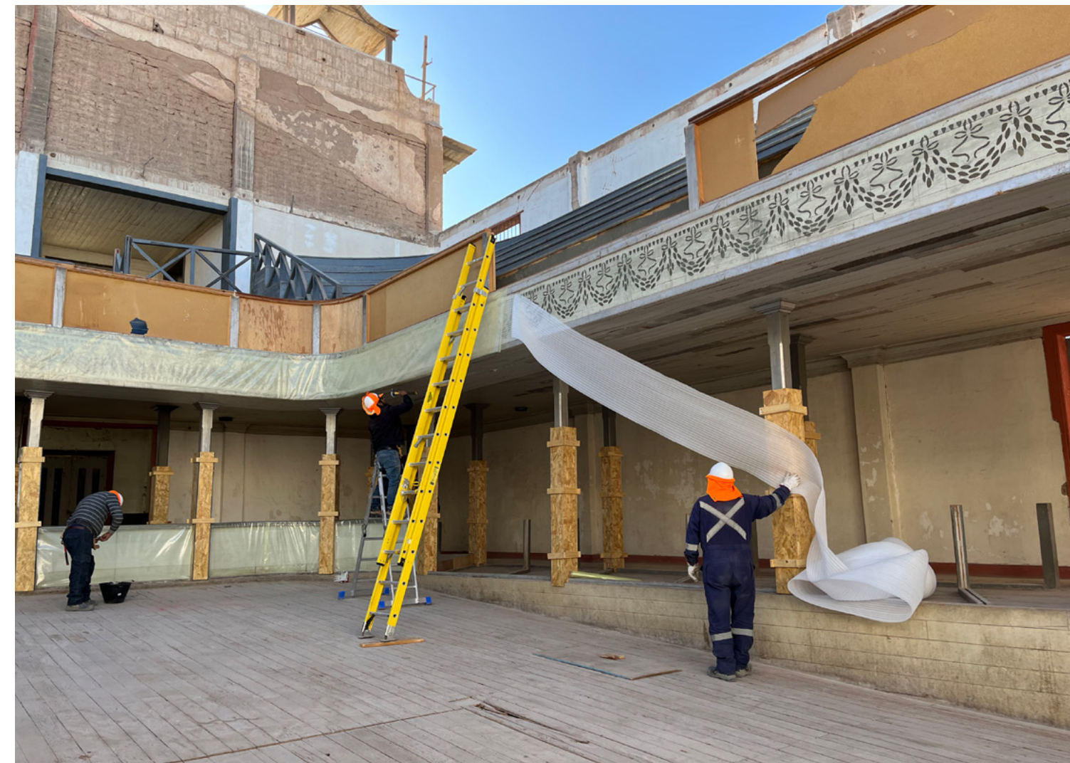
Protecciones de pinturas murales en la galería.
