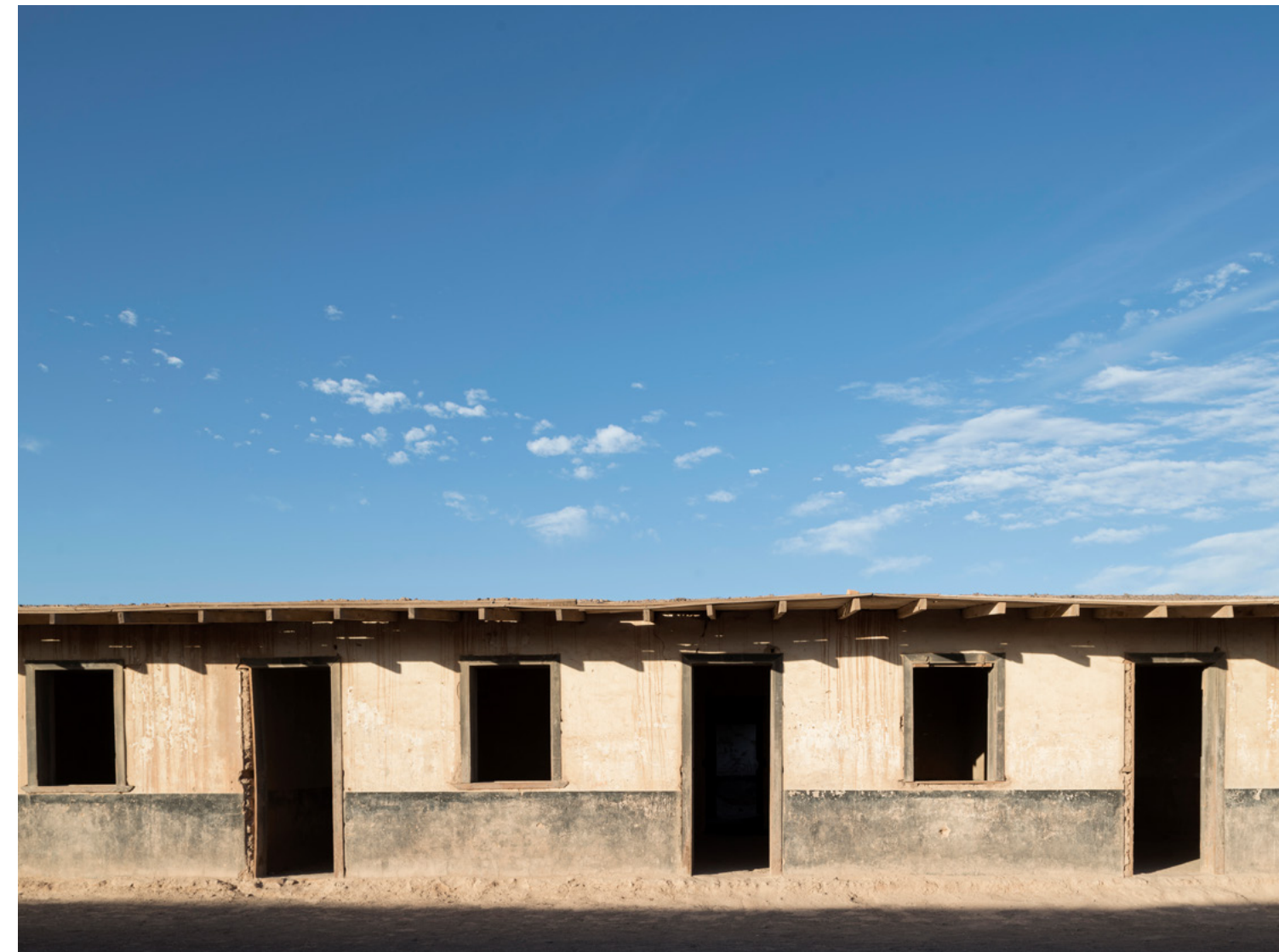
Viviendas de los trabajadores del salitre en el sector del campo de prisioneros.
