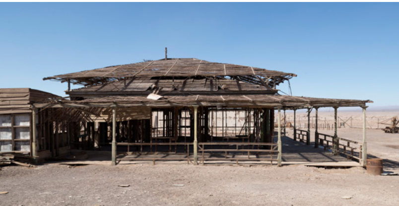
Vestigios de la casa del administrador.
